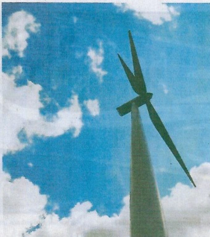
Windkraftanlagen sind auf Feldern zwischen Landau und Gassterfeld sowie im Stadtwald von Landau geplant. Foto: Haß
