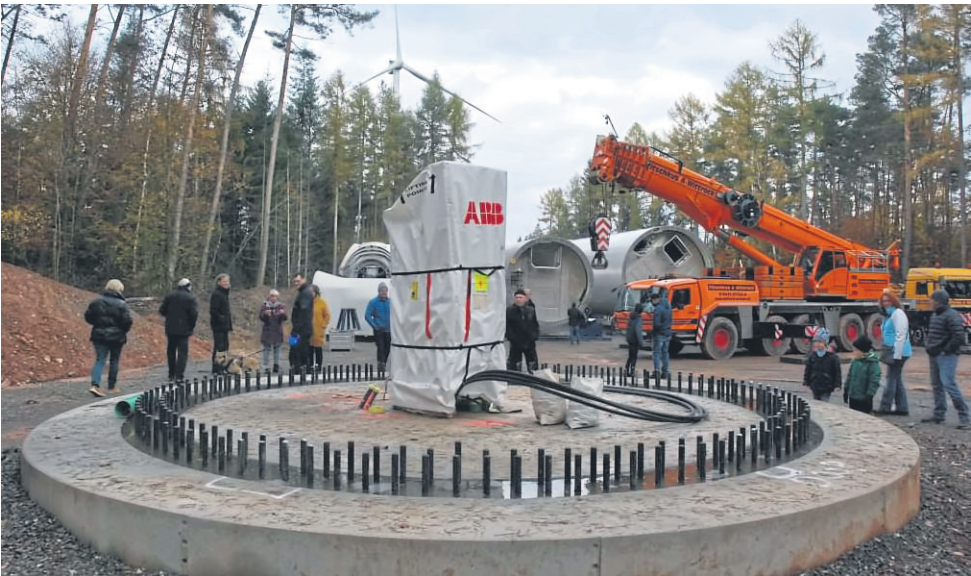
Das Fundament für die zweite Windkraftanlage im Stadtwald Landau ist inzwischen fertiggestellt worden. Bis Anfang des kommenden Jahres sollen beide Windmühlen in Betrieb gehen.
