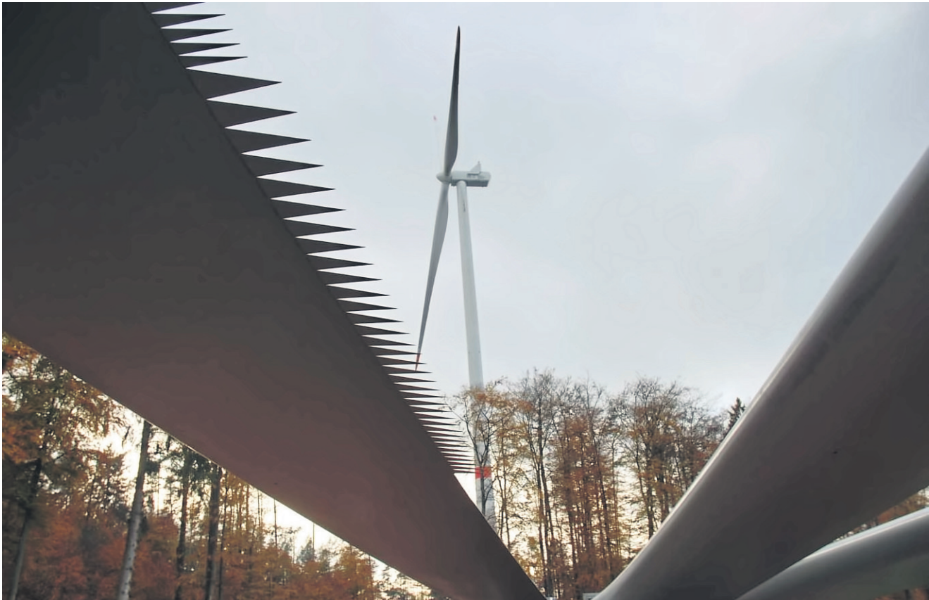
Zwei Windkraftanlagen baut Abo Wind im Stadtwald Landau für die von deutschen Stadtwerken getragene Gesellschaft Trianel. Das Bild zeigt Rotorblätter, die für die zweite Anlage angeliefert wurden, vor der in der kommenden Woche in Betrieb gehenden Windmühle.
