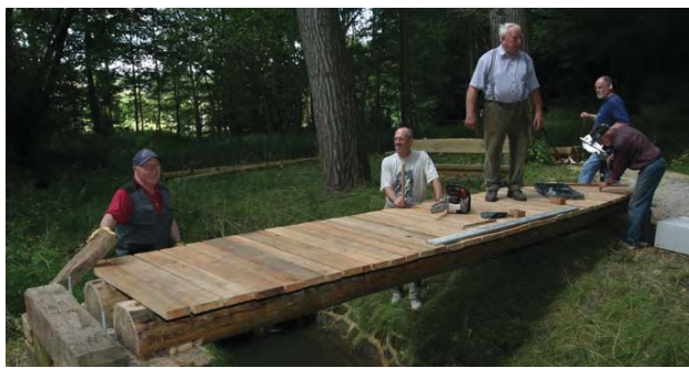
Brückenbau an der Fischtreppe an der Wasserkunst in Eigenleistung.
