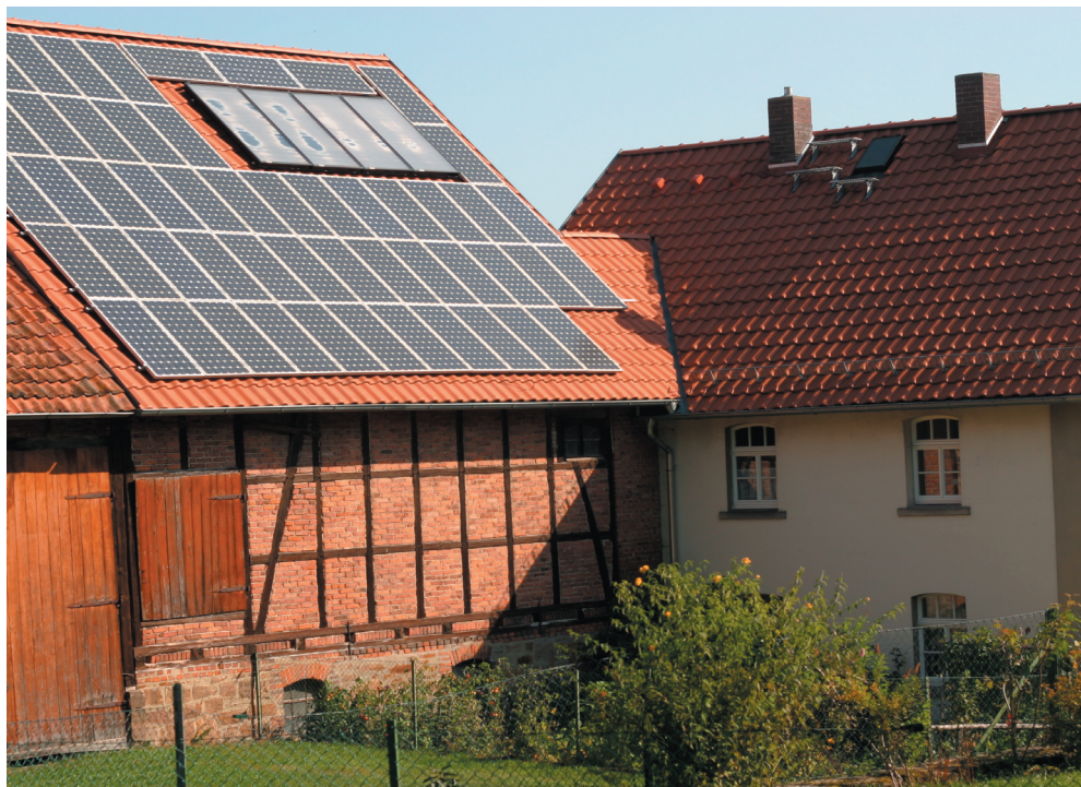
Neue Technik auf alter Scheune (Hildebrands) – Doris und Marcus Winkler haben 2008 damit deutlich mehr Strom gewonnen als ursprünglich kalkuliert.
